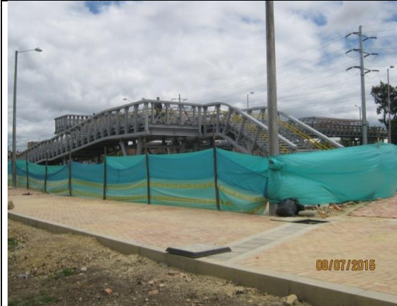
Foto No 5. Espacio público del costado norte. Puente peatonal de ingreso. el cual está a cargo de contratista COINVER S.A -LIBERTY SEGUROS
