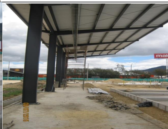
Foto 4. Plataforma de Buses intermunicipales el cual está a cargo de contratista COINVER S.A- LIBERTY SEGUROS
