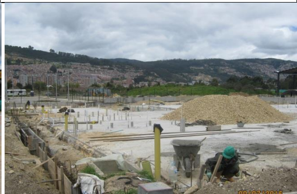
Foto No 8. Plazoleta de acceso: se observa el acero de refuerzo del muro de contención que confinará la plazoleta de acceso y el patio de maniobras. Muro que se empezó a construir. el cual está a cargo de contratista COINVER S.A -LIBERTY SEGUROS.
