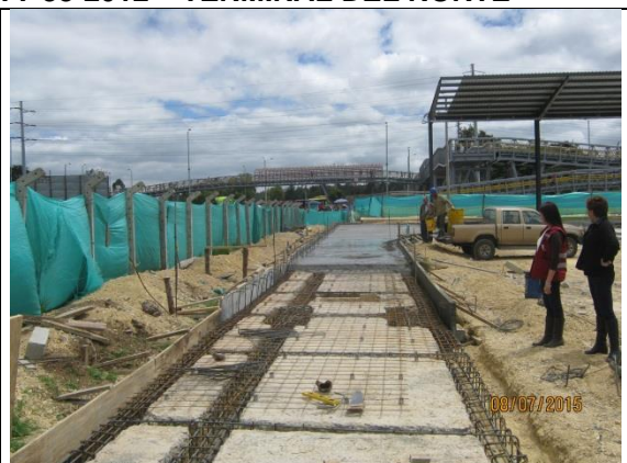
Foto No 2 oficina administrativas. el cual está a cargo de contratista COINVER S.A -LIBERTY SEGUROS
