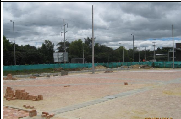
Foto No 7. Plazoleta de acceso: actualmente se está trabajando en este, el cual está a cargo de contratista COINVER S.A -LIBERTY SEGUROS.
