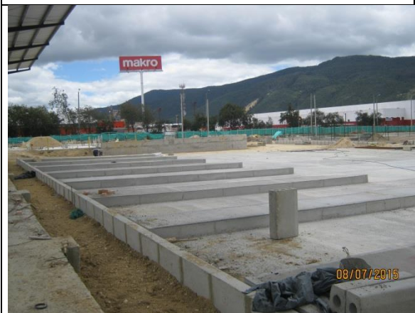
Foto 3. Plataforma de Buses intermunicipales y patio de maniobra conformación del espacio público con bordillos de concreto. el cual está a cargo de contratista COINVER S.A-LIBERTY SEGUROS
