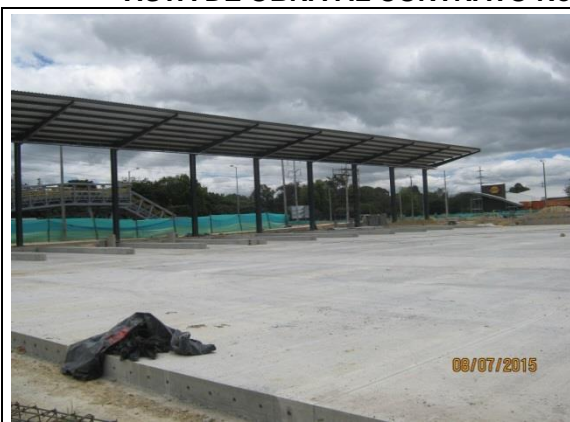
Foto 1 Plataforma de Buses intermunicipales y patio de maniobra. el cual está a cargo de contratista COINVER S.A- LIBERTY SEGUROS
